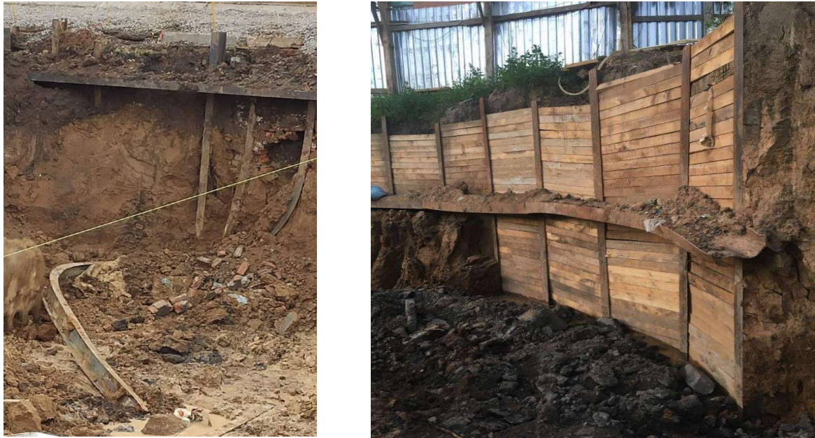
Рисунок 2 – Вигляд огородження котловану
