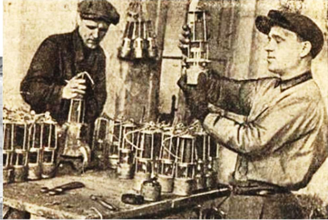
Проверка шахтерских ламп на заводе «Свет шахтера» (Харьков, 1932 г.)
